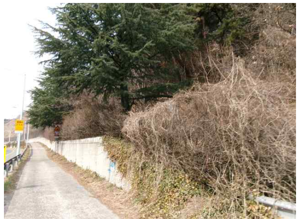
낙석방지울타리 및 하부 전경
