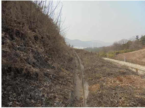
1소단 배수로 전경
