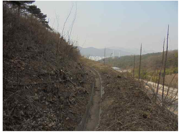
2소단 배수로 전경
