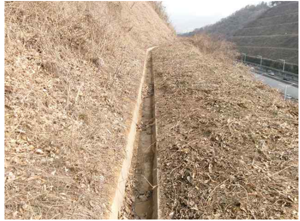
2소단 배수로 전경
