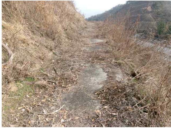
1소단 배수로 전경
